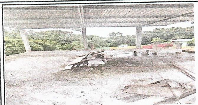
Foto 1: Se sustituye lámina perforada por lámina troquelada Aluzinc calibre 26 con elementos de fijación.
